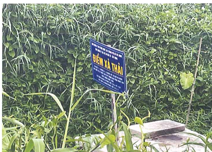
Khu vực điểm xả nước thải sau xử lý
