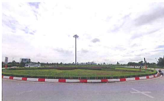
Nút giao thông đường D1- Võ Chí Công
