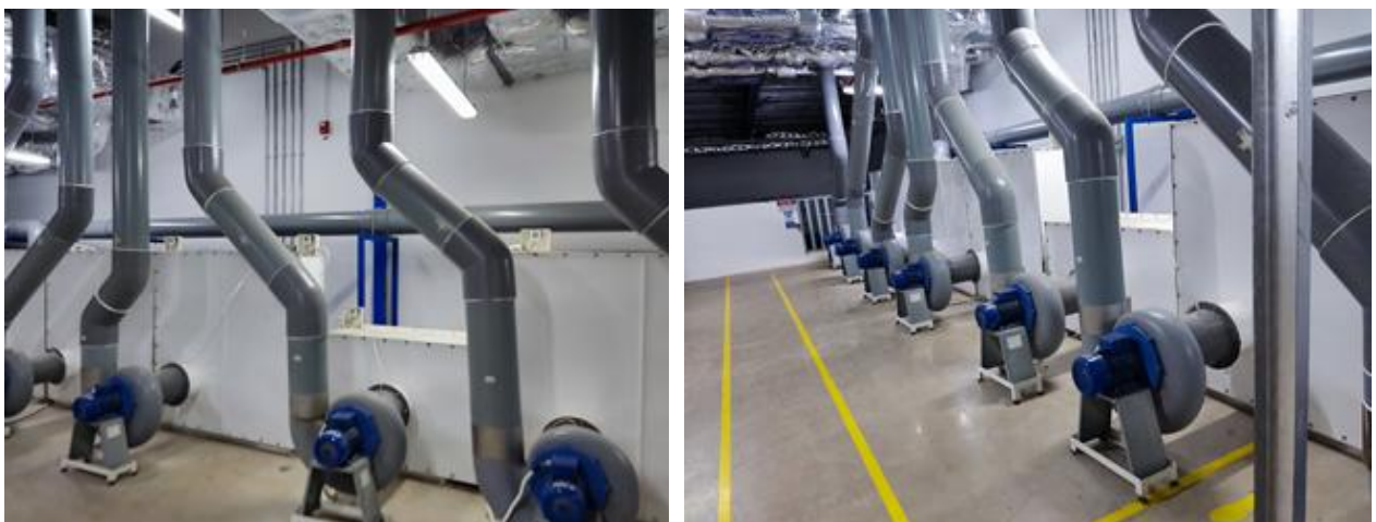
Hình 3.13: Hình ảnh các bộ lọc và ống thoát khí thải sau xử lý tại các tủ hút
