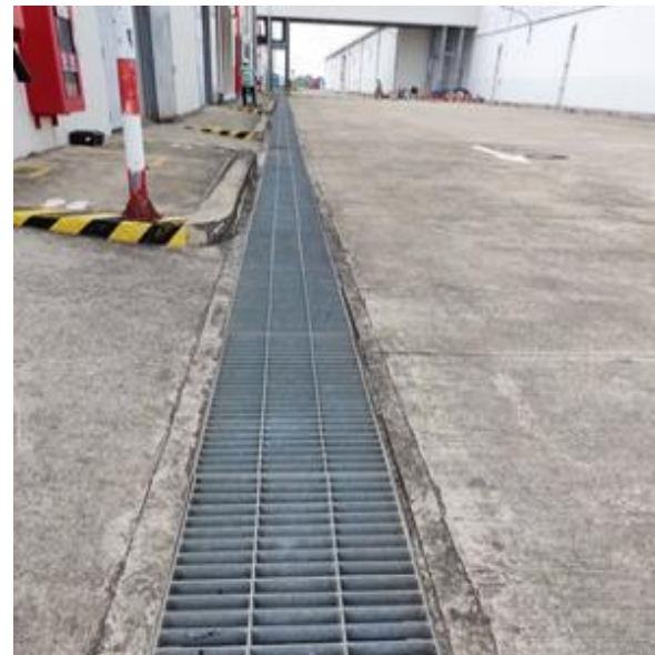
(Mương hở thu gom nước mưa tại nhà máy)
