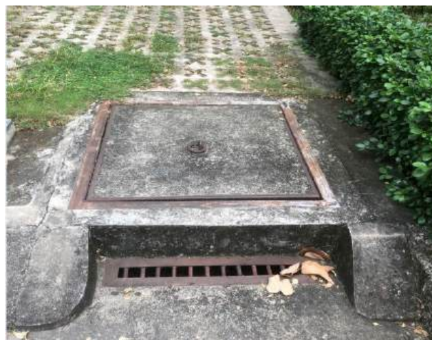
Hình 3. 4: Thu gom, thoát nước mưa trên mặt bằng
