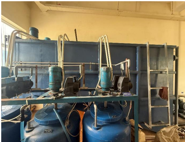
a. Cụm bể hóa lý (Khuấy trộn – Phản ứng – Lắng hóa lý)
