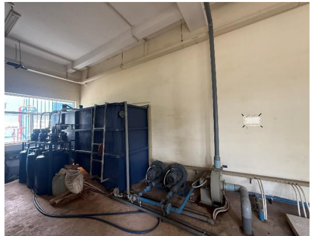
a. Cụm bể hóa lý (Khuấy trộn – Phản ứng – Lắng hóa lý)
