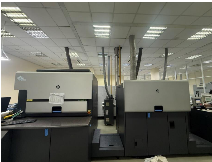
Hình 3.17 Đường ống thu gom khí thải phát sinh từ máy in HP
