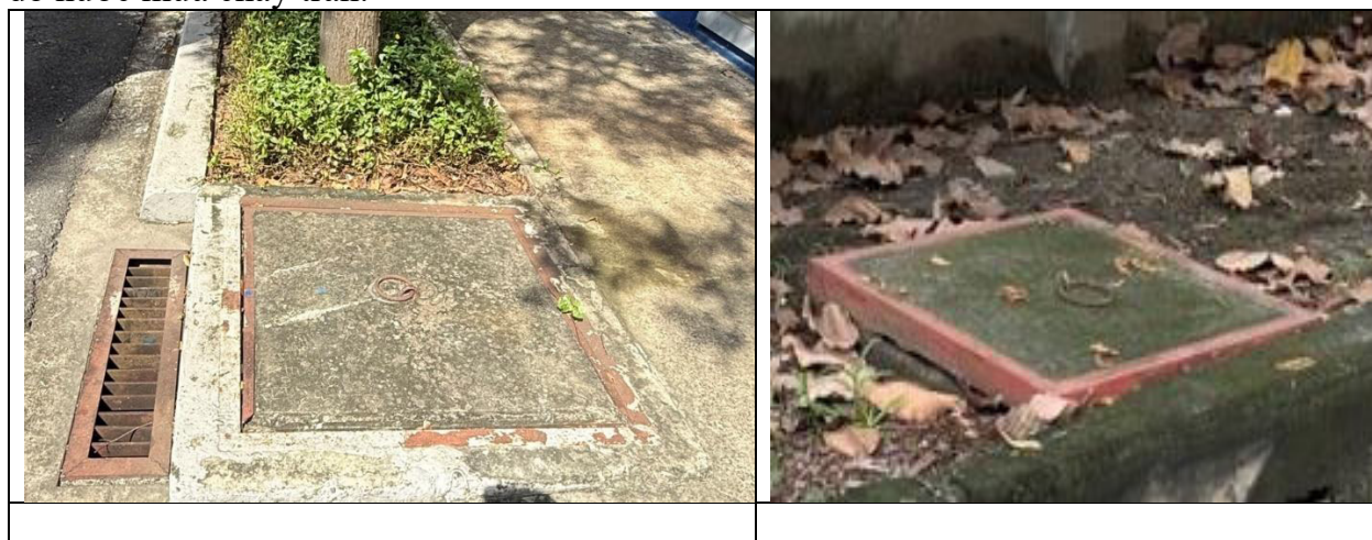
Hình 3.2 Hố ga nước mưa
